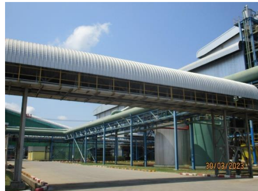
รูปที่ 21 ระบบสายพานลำเลียงแบบปิดครอบ
