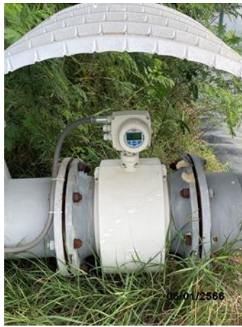
รูปที่ 27 Flow meter บริเวณระบบบำบัดน้ำเสีย
