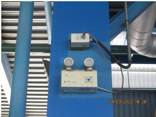
รูปที่ 88 ไฟส่องสว่างฉุกเฉินภายในพื้นที่โครงการ
