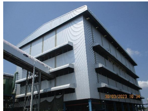
รูปที่ 89 การปิดครอบแหล่งกำเนิดเครื่องจักรที่มีเสียงดัง
