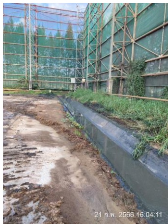
รูปที่ 8 รางระบายน้ำรอบลานกองกากอ้อย
