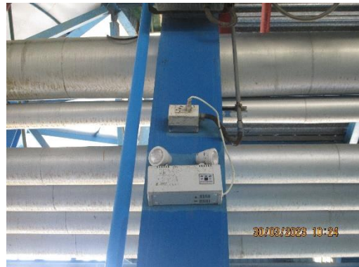
รูปที่ 88 ไฟส่องสว่างฉุกเฉินภายในพื้นที่โครงการ
